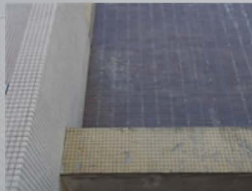
透明樹脂工法 経年劣化 (例)
