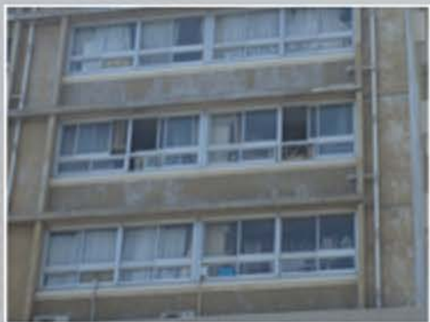
透明樹脂工法経年劣化（例）
