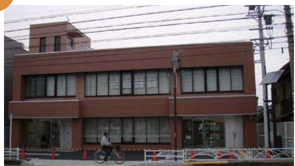
タイル仕上げ
