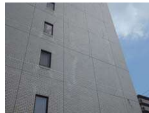
全面改修3回目後 (例)
