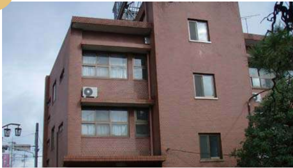
タイル仕上げ
