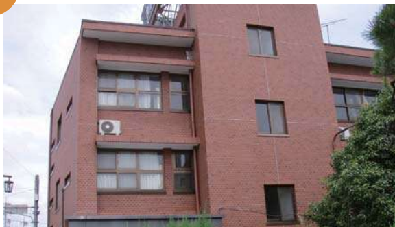
タイル仕上げ
