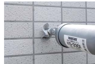
④樹脂注入
